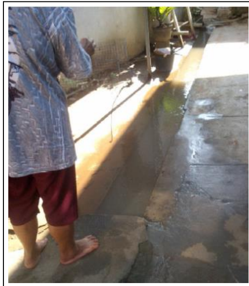
Gambar 7. Contoh Kondisi Saluran Drainase yang Tidak Terhubung dengan Sistem Drainase Perkotaan Sehingga Menimbulkan Genangan
